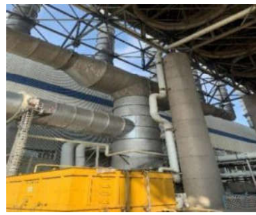
图 4.2-2 #1 机组高背压改造通路
